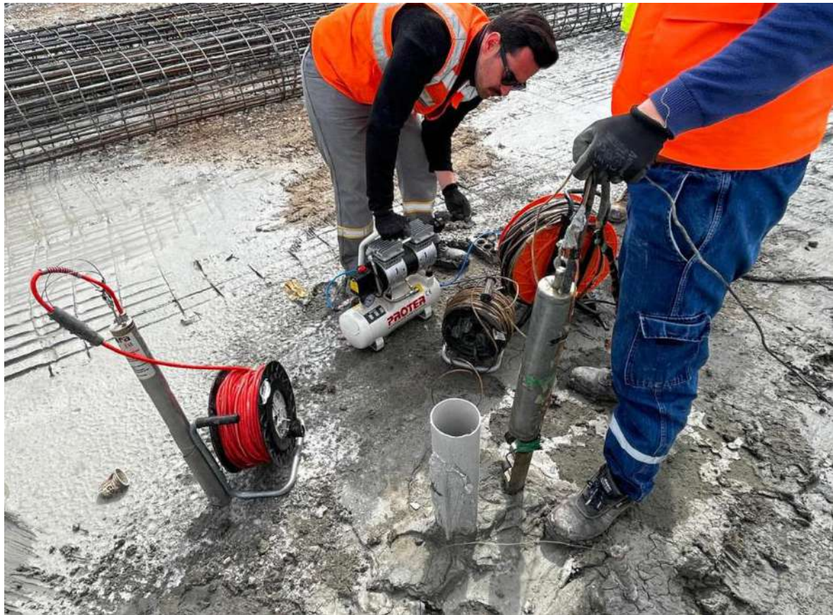
Şekil 2. Cross-Hole testi yapımı (genel imalat görüntüsü ve ölçüm aletleri görüntüsü)
