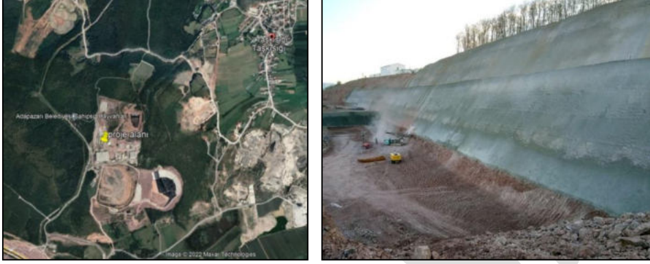
Fotoğraf 1 - İnceleme alanı a) uydu görüntüsü b) çivili iksa uygulama görüntüsü
