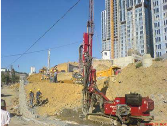
Şekil 7. Jet-Grouting İmalat Görüntüsü
