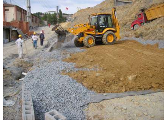
Şekil 8. GDİ Duvar İmalat Görüntüsü
